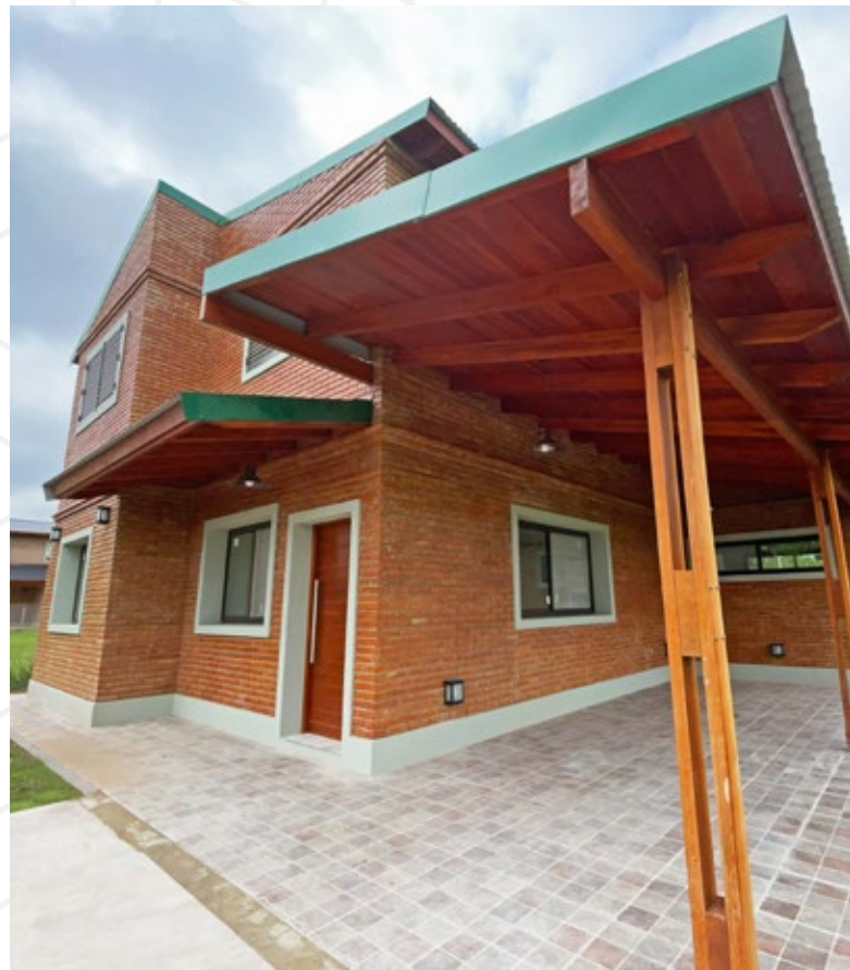
▲ Vista exterior a la vivienda entregada, calidad y detalles de terminación inmejorables.
